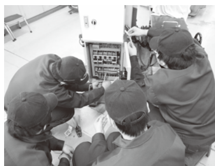
機械保全実習
