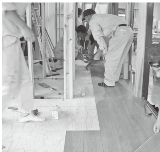
建築施工実習
