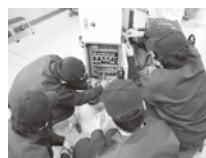
機械保全実習
